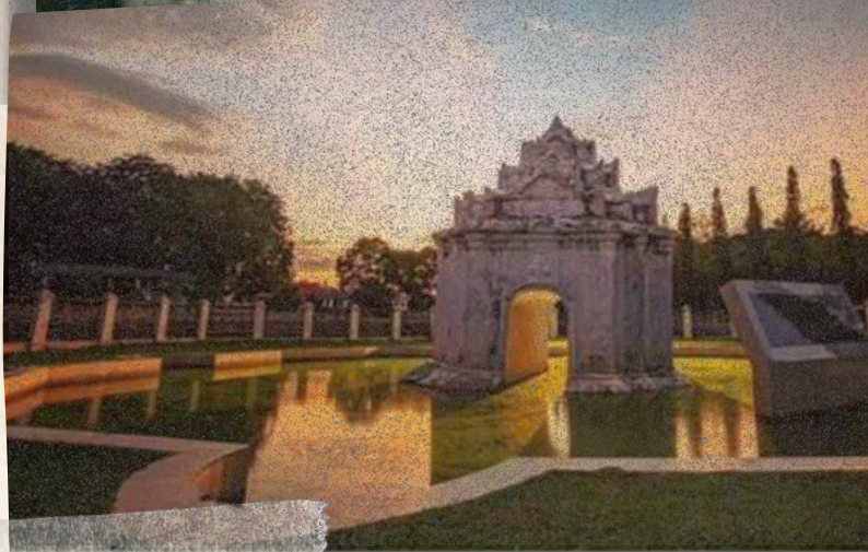
Pintu Khob (Tempat Permandian)
